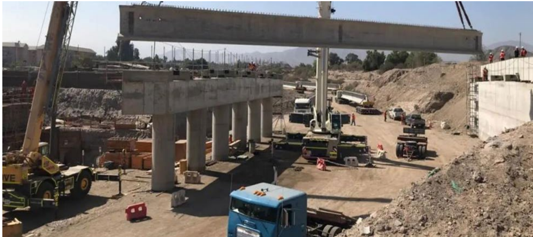
Instalación primeras vigas Puente Diego de Almagro, Copiapó
