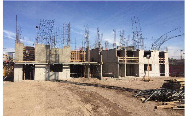
Proyecto Habitacional Punta Negra Norte, Copiapó; 120 viviendas
