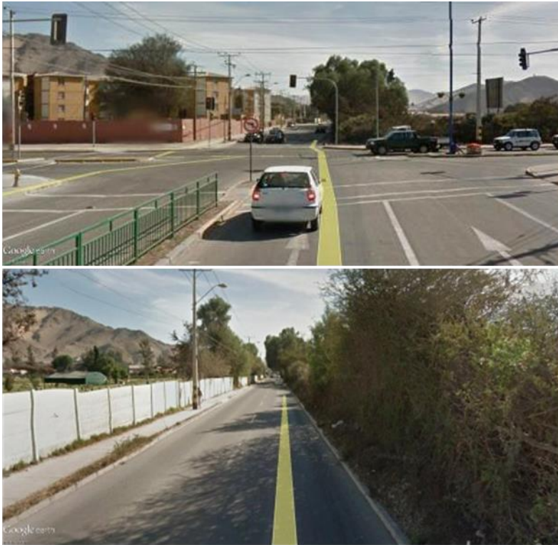
Construcción Doble vía Av. El Palomar.
