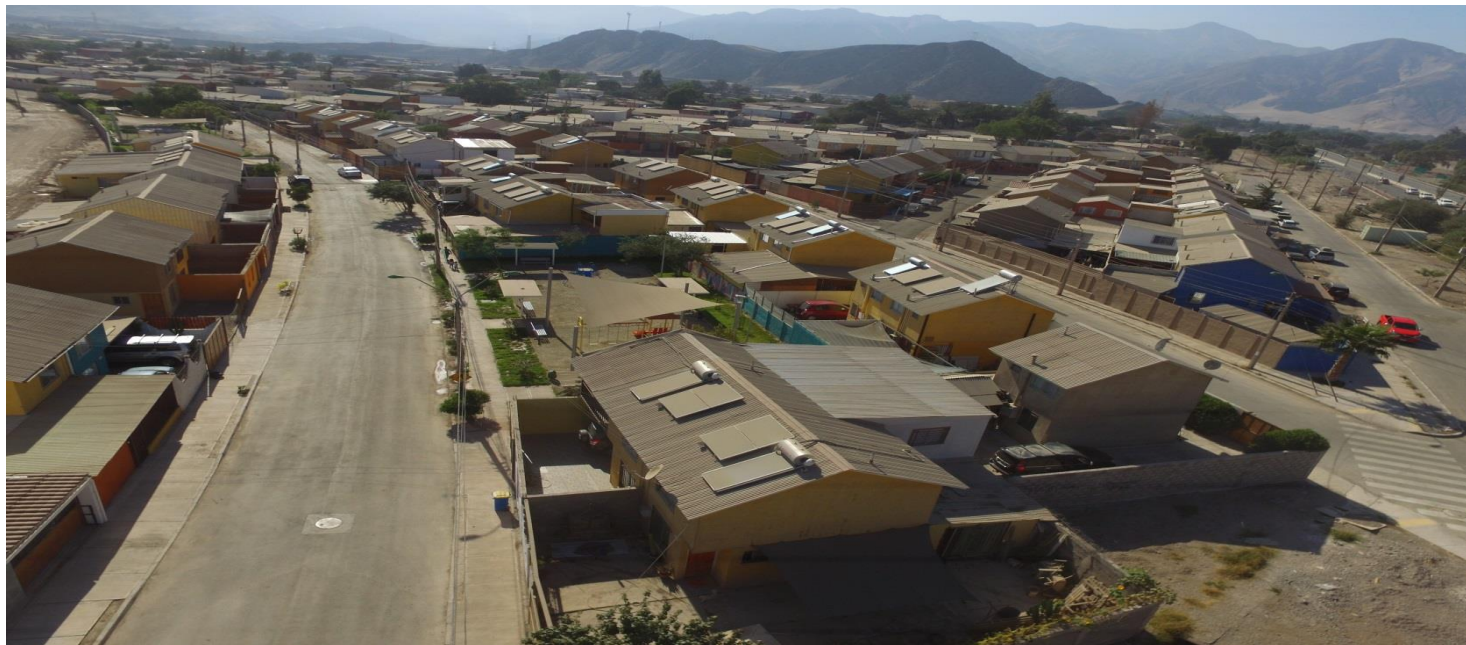
Instalaciones de Sistemas Solares (Paneles Fotovoltaicos y Colectores Solares), Villa Copayapu, Copiapó
