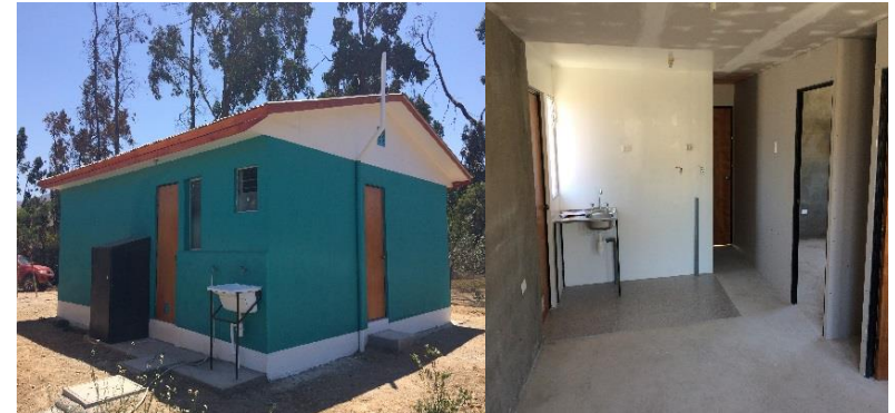
Proyecto Habitacional Sitio Propio Santa Teresa, Freirina; 7 viviendas
