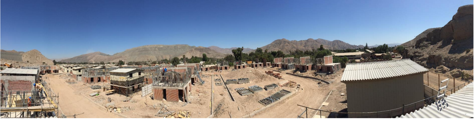
Proyecto Habitacional Las Vertientes I, Tierra Amarilla; 105 viviendas
